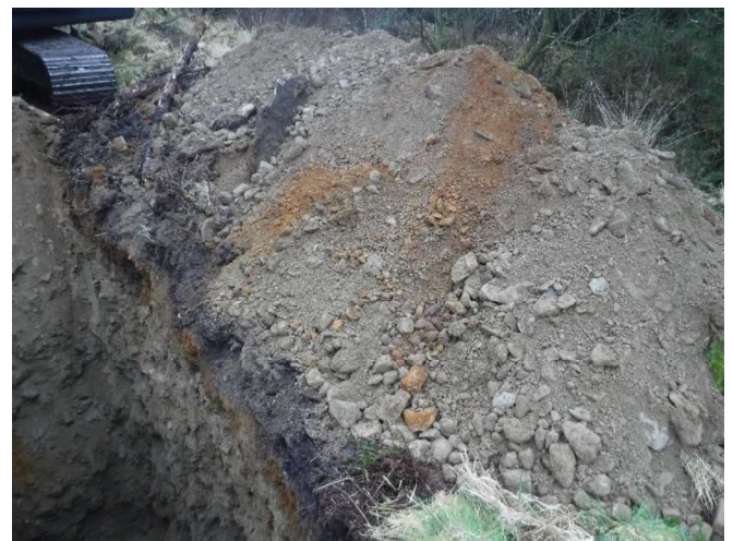
Figure 89 H:\21C101_Ballinagree TP Photos\Photos\TP25\DSCF4014.JPG
