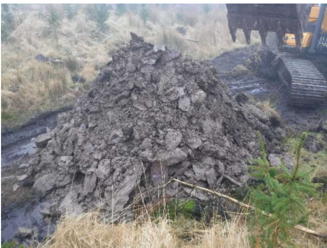
Figure 38 H:\21C101_Ballinagree TP Photos\Photos\T20A\DSCF4270.JPG
